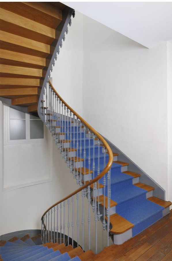
↑ Pose d'escaliers débillardés pour un établissement bancaire
